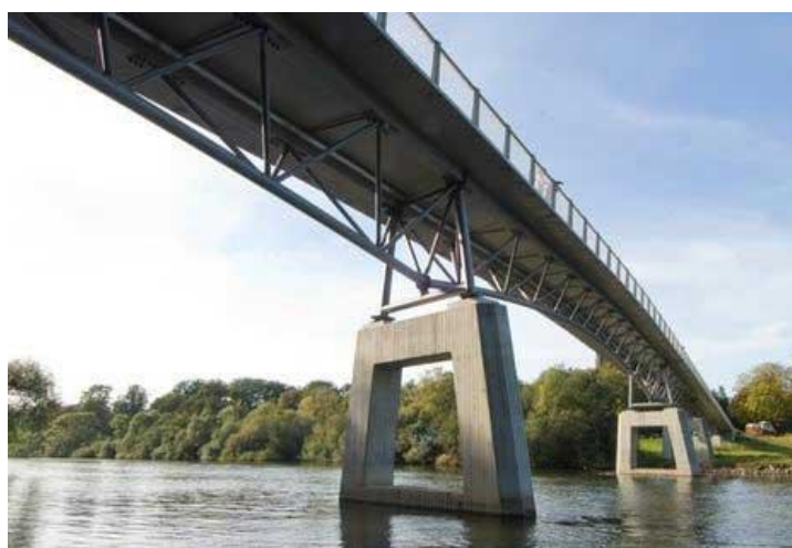
9.2 сурет — 2 түрдегі аралық құрылысы бар көпір (болат формадағы бетонды жапқыш)
