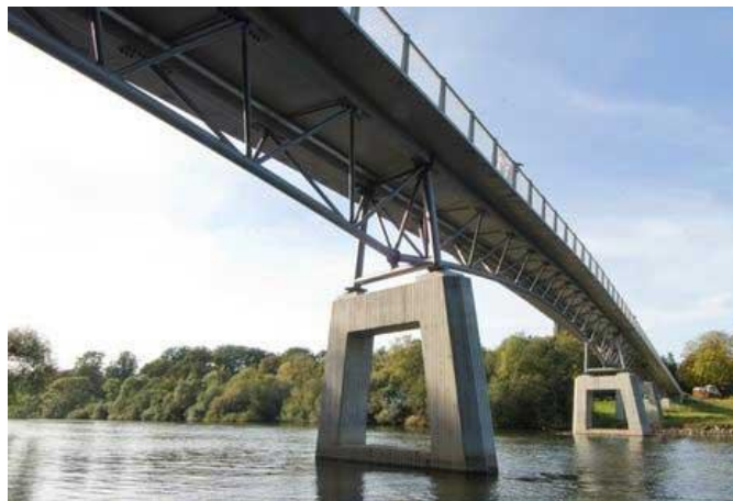
Рисунок 9.2 — Мост с пролетными строениями типа 2 (бетонный настил по стальной ферме)
