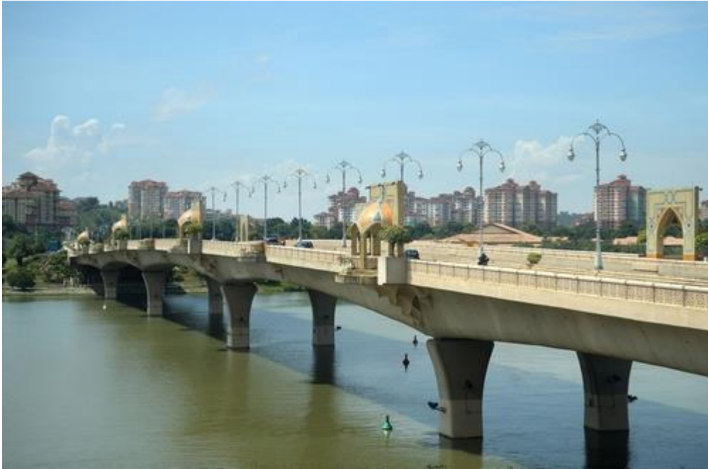
9.3 сурет — 3 түрдегі аралық құрылысы бар көпір
