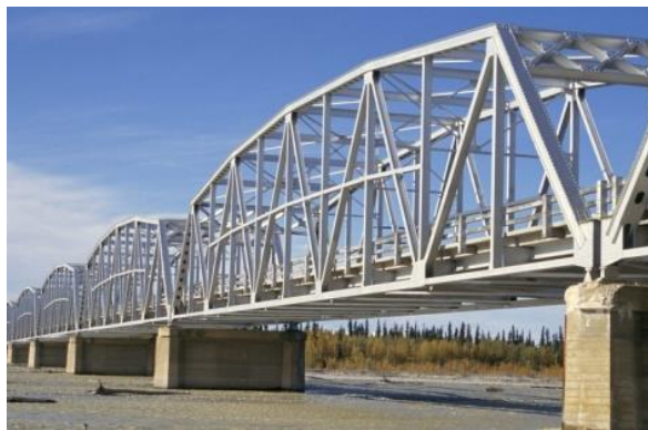
9.1 сурет — 1 түрдегі аралық құрылысы бар көпір 2 түр – Құраушы конструкциялардан жасалған аралық құрылыс (9.2 сурет).
